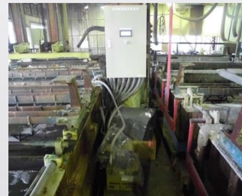
吊掛けキャリアめっきライン
