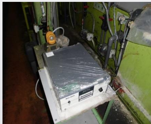
吊掛けエレベータめっきライン
